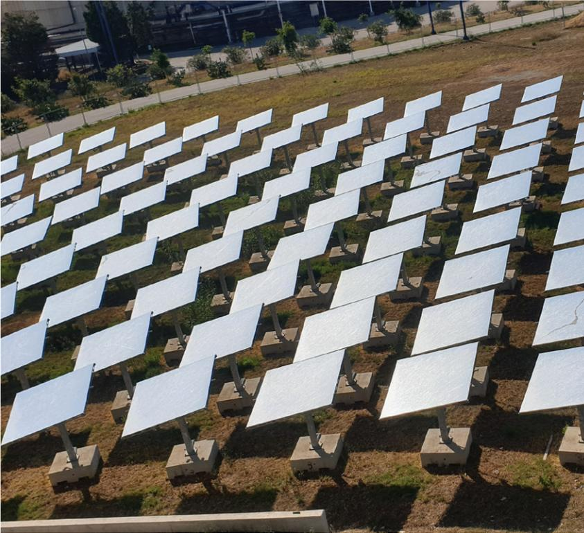
Il sistema Magaldi STEM®- CST è costituito da un campo specchi primari (eliostati) e da un riflettore secondario (beam-down), collocato al sopra di un ricevitore solare, posizionato a terra, che funge da batteria di accumulo termico. Il campo specchi capta l'energia solare, la riflette sullo specchio secondario che la concentra, a sua volta, nel ricevitore solare, all'interno del quale è presente un letto fluidizzato, costituito da particelle di sabbia come mezzo di accumulo termico
